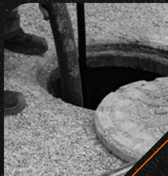
LIMPIEZA Y EVACUACIÓN DE POZOS SÉPTICOS.
