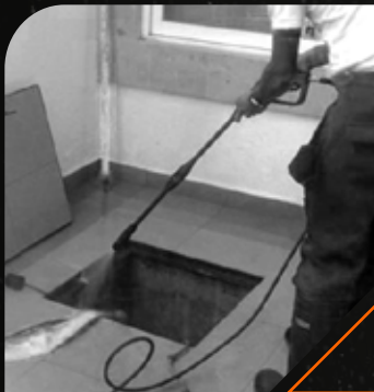
LIMPIEZA Y CLORIFICACIÓN DE CISTERNAS.
