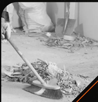
LIMPIEZA DE OBRA.
