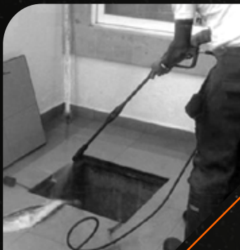
LIMPIEZA Y CLORIFICACIÓN DE CISTERNAS.
