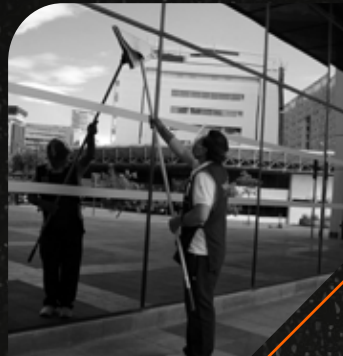
TRABAJOS EN ALTURA (VIDRIOS, VENTANAS, FACHADA, ALUCOBOND).
