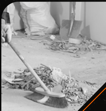
LIMPIEZA DE OBRA.
