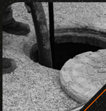
LIMPIEZA Y EVACUACIÓN DE POZOS SÉPTICOS.
