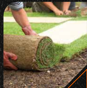
INSTALACIÓN, REPARACIÓN Y SUSTITUCIÓN DE CÉSPED.
