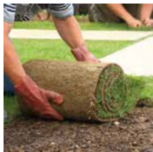
INSTALACIÓN, REPARACIÓN Y SUSTITUCIÓN DE CÉSPED
