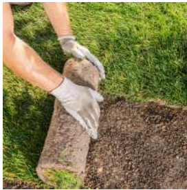
INSTALACIÓN, REPARACIÓN Y SUSTITUCIÓN DE CÉSPED
