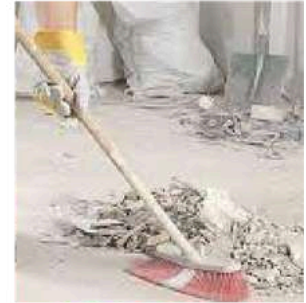
LIMPIEZA DE OBRA
