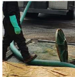
LIMPIEZA Y EVACUACIÓN DE POZOS SÉPTICOS
