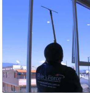
TRABAJOS EN ALTURA VIDRIOS - VENTANAS FACHADAS - ALUCOBOND
