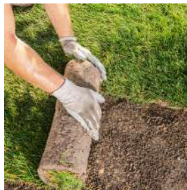
INSTALACIÓN, REPARACIÓN Y SUSTITUCIÓN DE CÉSPED
