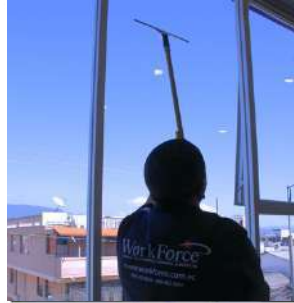
TRABAJOS EN ALTURA VIDRIOS - VENTANAS FACHADAS - ALUCOBOND
