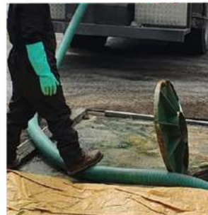
LIMPIEZA Y EVACUACIÓN DE POZOS SÉPTICOS
