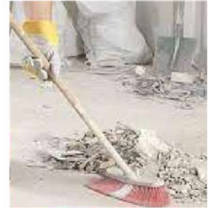
LIMPIEZA DE OBRA
