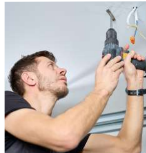
MANTENIMIENTO DE ILUMINACIÓN
