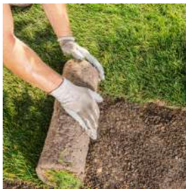
INSTALACIÓN, REPARACIÓN Y SUSTITUCIÓN DE CÉSPED
