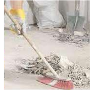
LIMPIEZA DE OBRA
