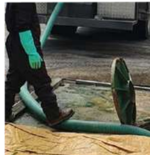
LIMPIEZA Y EVACUACIÓN DE POZOS SÉPTICOS
