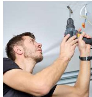
MANTENIMIENTO DE ILUMINACIÓN
